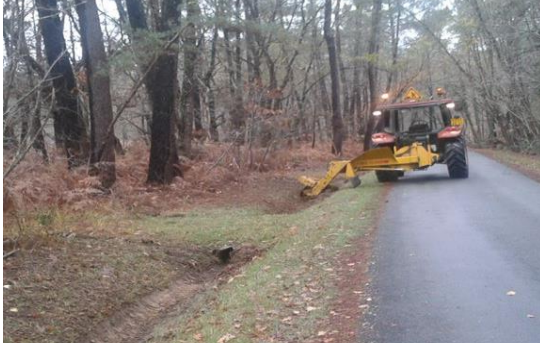
Opérations de curage et création de fossés pour limiter les dégâts des eaux pluviales
