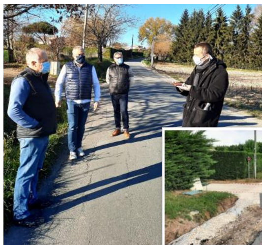
La rue de Biras avant les travaux lors des réunions préparatoires
